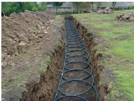
*Грунтовая разводка трубопровода*
