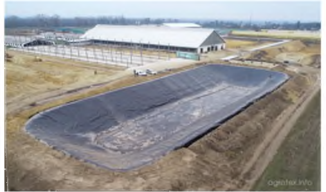
Рисунок 1. Примеры устройства навозохранилища (пометохранилища) по типу «лагуна» (слева заполненная, справа незаполненная).
