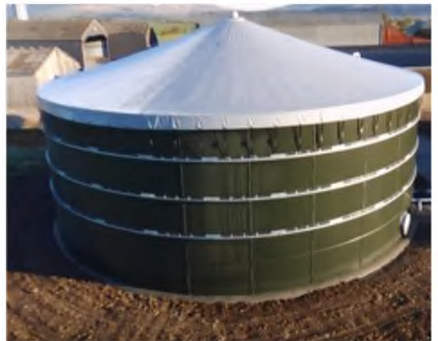
Рисунок 2. Примеры устройства навозохранилища (пометохранилища) по типу «наземный резервуар» (слева открытый, справа закрытый).
